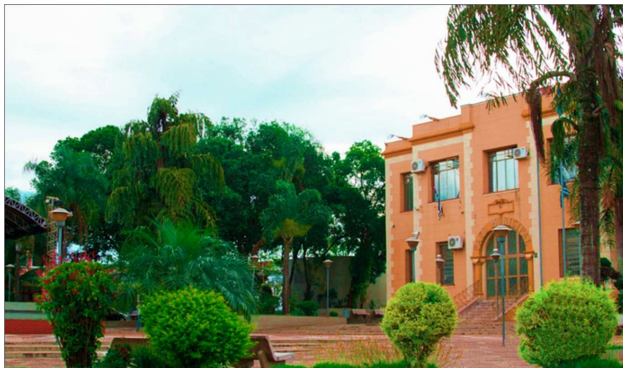
Figura 75: Paço Municipal. Fonte: Gi Malavazi Fotografia (2016).
