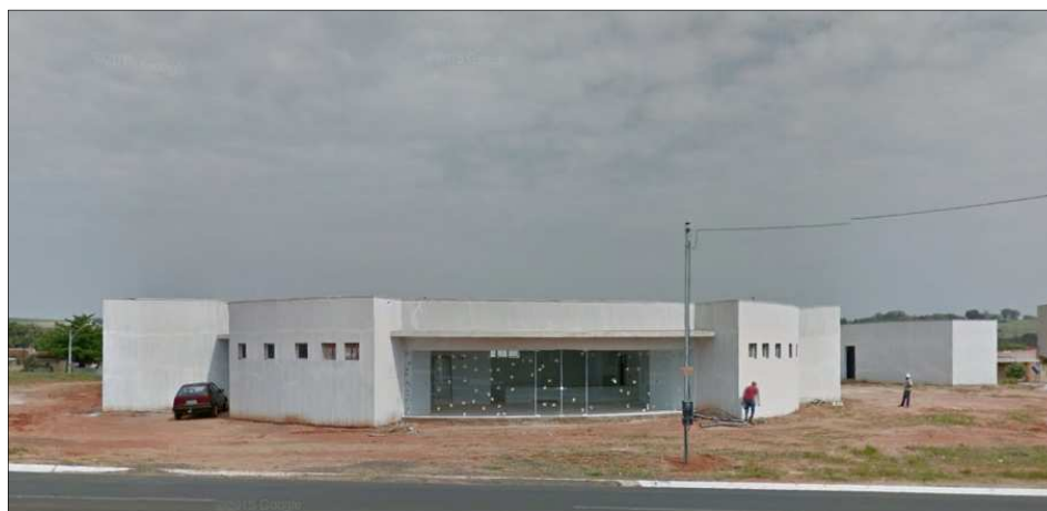
Figura 39: Unidade de Pronto Atendimento em construção Fonte: Google Street View (2015)
