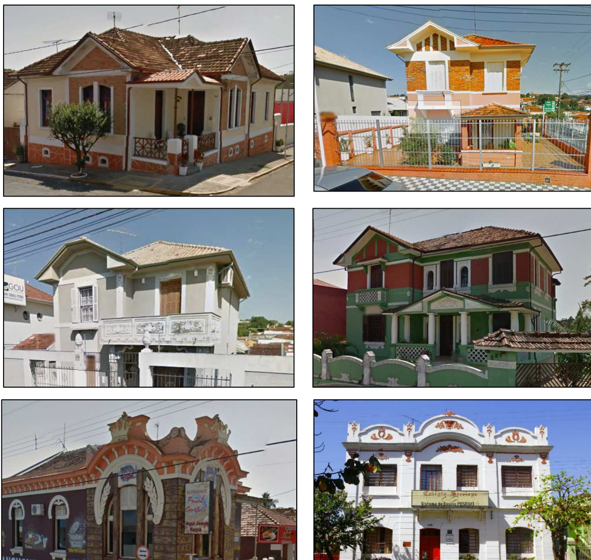
Figura 69: Casario na região central da cidade de Agudos. Fonte: GoogleStreet View (2016).
