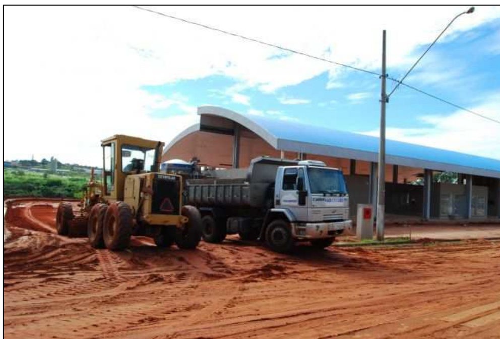
Figura 36: Obras na nova rodoviária de Agudos. Fonte: Prefeitura Municipal de Agudos (2016).
