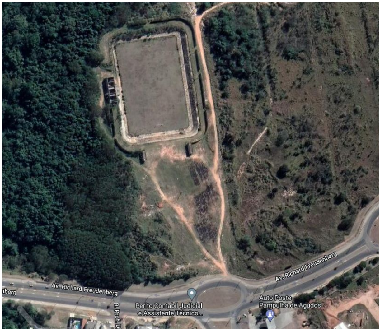
Figura 1 - Localização da obra. (Fonte: Google Earth,2022)
