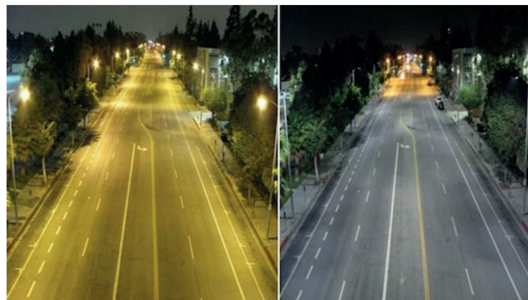
Foto 21 - Comparação entre trecho utilizando tecnologia Vapor de Sódio e tecnologia LED.
