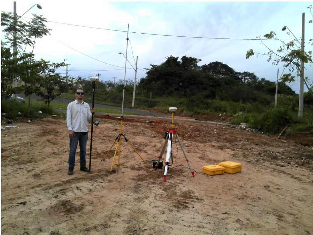
Figura 2 - Montagem da base próximo ao ponto de interligação.
