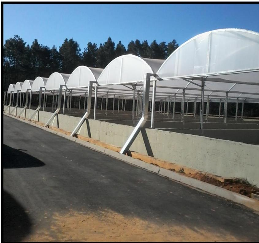
Figura 30 – Leitos de secagem de lodo
