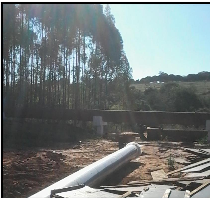
Figura 22 – Tubulação de entrada do esgoto na ETE
