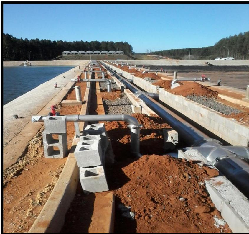
Figura 28 – Implantação do sistema de aeração
