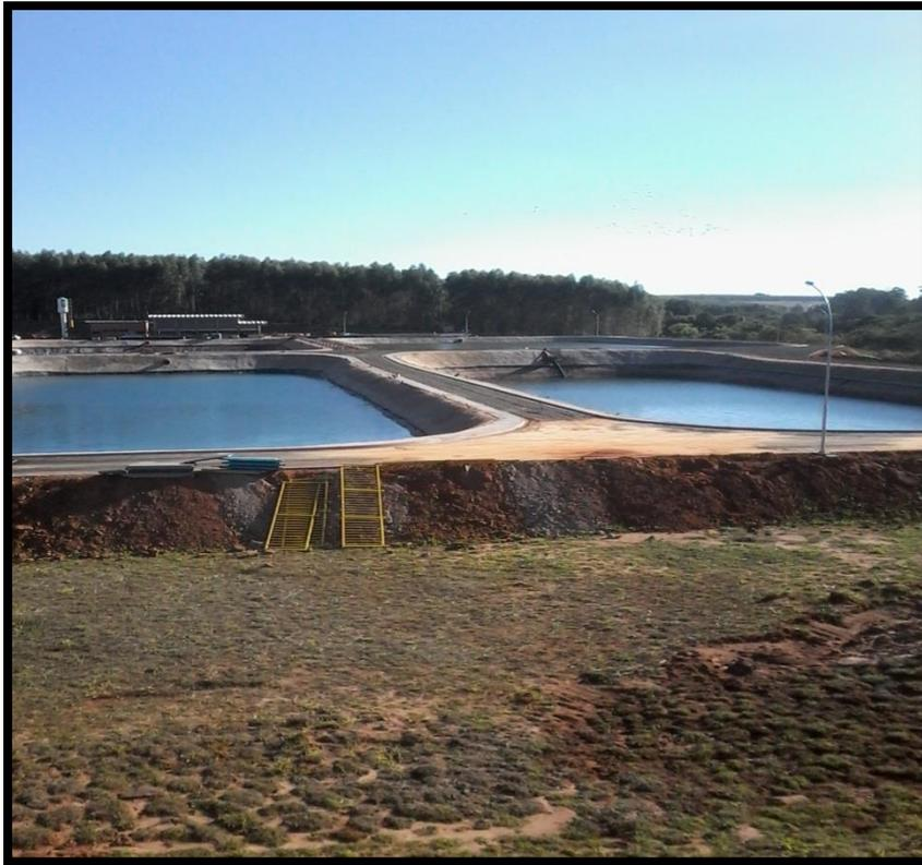
Figura 29 – Lagoas de decantação com água da chuva
