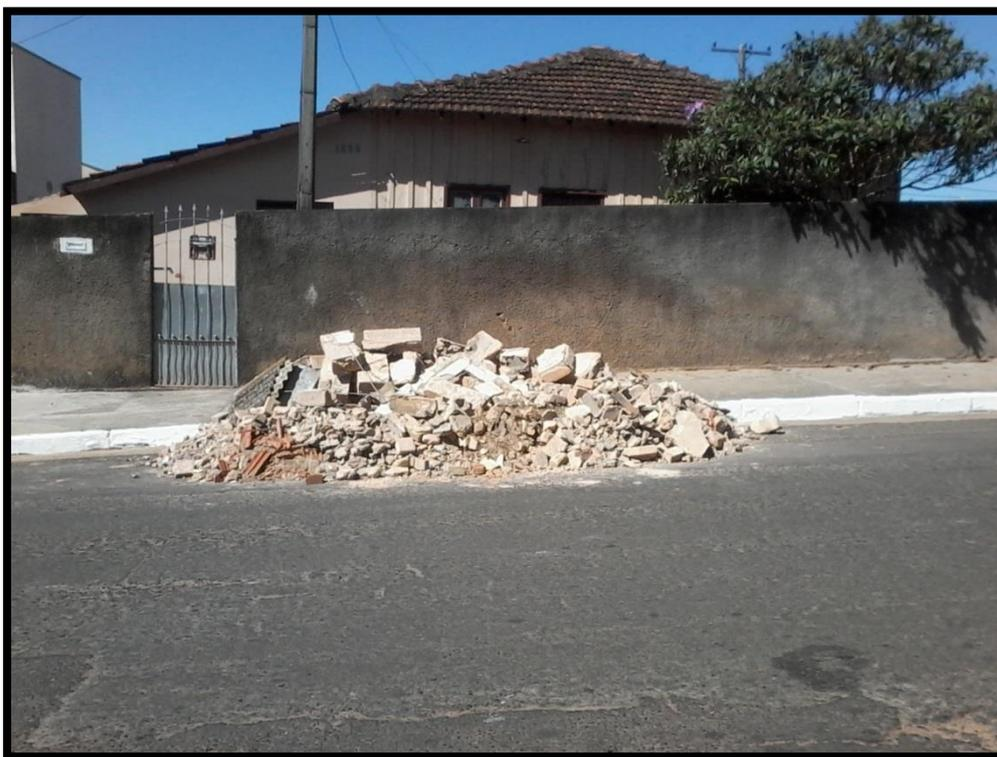
Figura 42 – Acondicionamento de RCC para coleta da prefeitura
