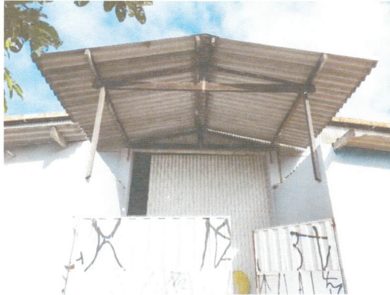
Figura 10- Cobertura da entrada pela R. Treze de Maio
